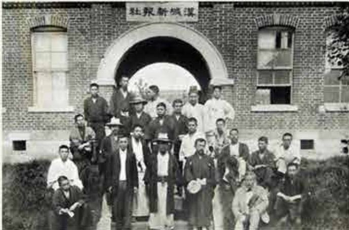
한성신보사 사옥이다. 단층 건물이다. 현관에 계단을 두어 건물을 들어 올렸다. 번사창, 백재학당도 비슷하다. 사옥은 벽돌조에 아치 현관을 갖고 있다. 창문 상인방은 편평하지로 했다. 키스톤(宗石)을 두고 약간 접는 형식이다. 청문은 크레센트와 도르레가 달린 4문짜리 문이 4개 창틀로 했다.
